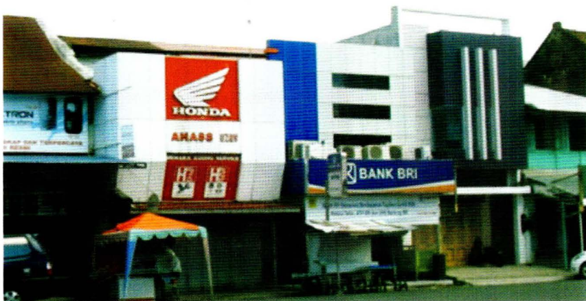
Kondisi beberapa bangunan yang merubah wajah kota di jalan pondok Kota Padang Koleksi Penulis
