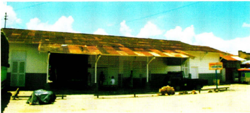
Stasiun Bukittinggi Koleksi BPCB Prov. Sumbar, Riau, dan Kepri.
