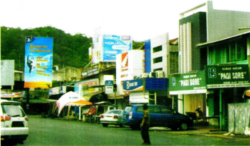
Kondisi beberapa bangunan yang merubah wajah kota di jalan pondok Kota Padang Koleksi Penulis
