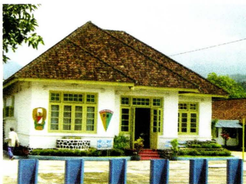
Bangunan Markas CPM Sumedang dilihat dari muka
