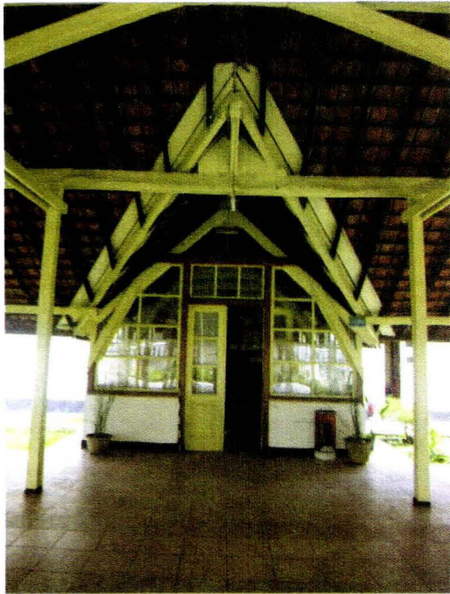
Tampak muka koridor tertutup yang kemudian menjadi satu ruang, menghubungkan pendopo dengan bangunan kantor
