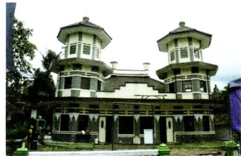
Kondisi bangunan masjid setelah renovasi tahun 2010
