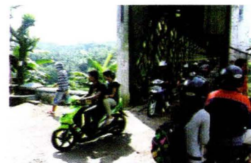
Selain sebagai Lintasan Kereta Api (Atas) Jembatan juga sebagai Lintasan Kendaraan Beroda Dua (Bawah)
