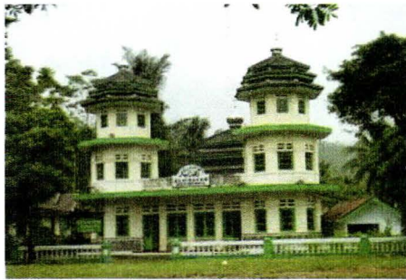
Kondisi bangunan Masjid sebelum renovasi tahun 2010
