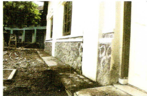
Kondisi dinding masonry dan sisa lantai asli
