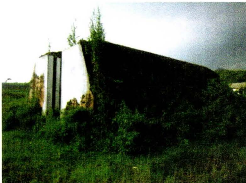
Bagian muka bunker tampak bagian pintunya
