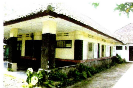
Pilar Semu dan Hiasan Masonry pada dinding
