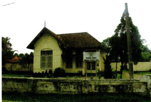
Facade bangunan rumah dinas Jl. Kartini No.E48. Bandingkan dengan foto 8, serupa tapi tak sama, terutama pada denah kamar depan yang memiliki jendela pada dinding facade.
