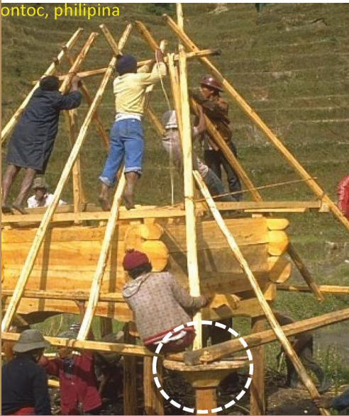
Gambar 19. Detail ‘piring cakram’ pada tiang rumah lumbung di Bontoc, Mountain Province, Filipina.
