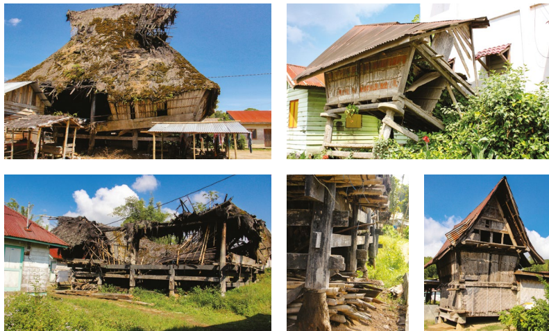
Gambar 13. Contoh beberapa rumah tradisional dan vernakular di Karo, Sumatra Utara yang sudah lapuk dan rusak serta sudah tidak dipergunakan atau dihuni. Foto : penulis
