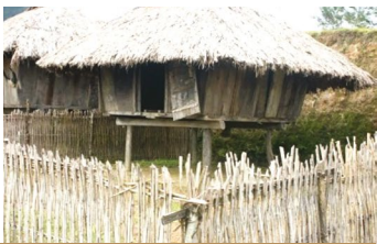
Gambar 19. Detail ‘piring cakram’ pada tiang rumah lumbung di Bontoc, Mountain Province, Filipina.
