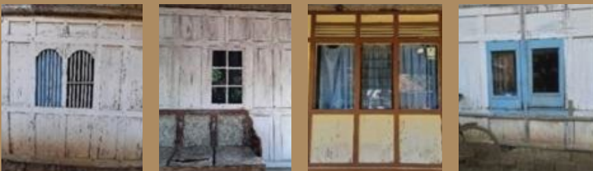
Gambar 34. Ragam pintu dan jendela (JHS, 2022)
