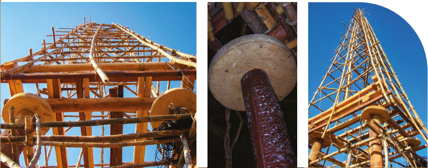
Gambar 17. Detail ‘piring cakram’ pada tiang rumah tradisional Sumba. Foto : penulis
