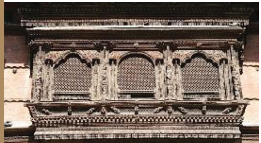
Gambar 30. Detil dinding dan lubang ventilasi berbentuk belah ketupat bangunan berkonstruksi kayu di Kompleks Istana Kuno di Nepal. (Sumber: www.istockphoto.com )
