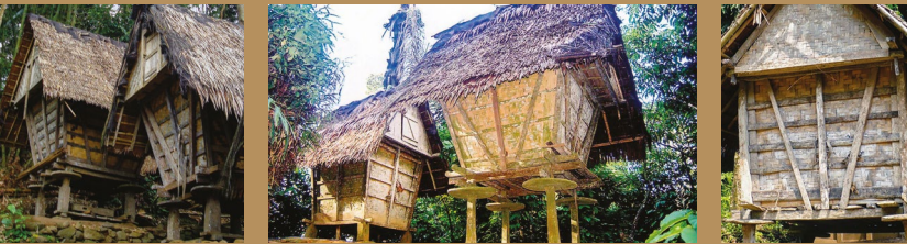
Gambar 16. Lumbung padi pada masyarakat Baduy yang disebut ‘Leuit’ dalam bahasa setempat, terdapat detail ‘piring cakram’ pada bagian tiangnya yang berfungsi sebagai penjebak tikus. Foto : internet
