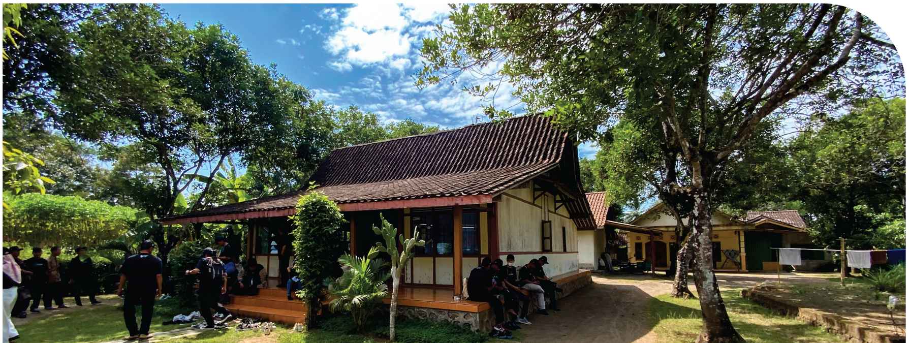
Gambar 12. Salah satu contoh adaptasi penambahan bangunan baru yang tidak mengganggu nilai rumah vernakular Borobudur karena skala, proporsi dan ketinggian bangunan baru tambahan tidak melebihi rumah asli. Foto: Prisca Bicawati 2024
