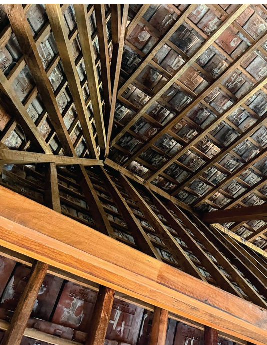
Gambar 7. Konstruksi atap limasan menggunakan kayu Foto: Nadia P. 2024
