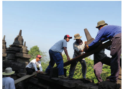
Foto 9, 10. Pembongkaran relung bagian teratas, berupa stupa atas relung pagar langkan (dok: BK Borobudur).
