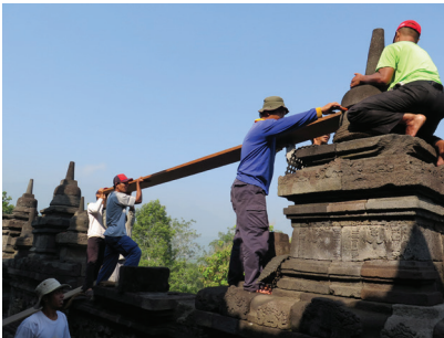
Foto 9, 10. Pembongkaran relung bagian teratas, berupa stupa atas relung pagar langkan (dok: BK Borobudur).
