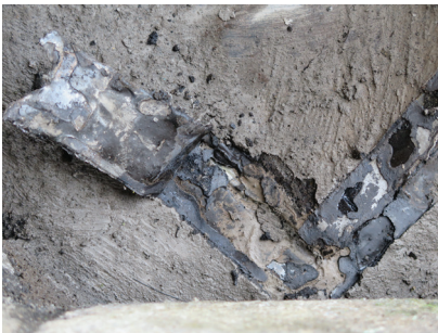
Foto 52, 53. Kondisi sambungan timbal yang kelihatan basah (dok: BK Borobudur).
