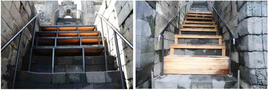
Gambar 14. Uji coba model pelapis tangga
