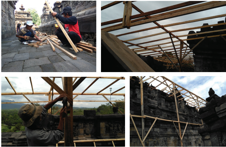
Foto 13-16. Pemasangan perancah yang terbuat dari kayu(dok: BK Borobudur).
