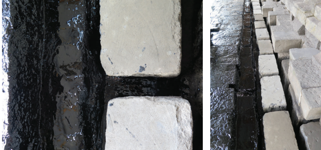
Foto 44, 45. Saluran drainase bawah lantai yang sudah dilakukan pelapisan kedap air (dok: BK Borobudur).
