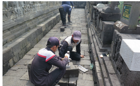
Perbaikan lantai lorong III Candi Borobudur (dok : BK Borobudur)
