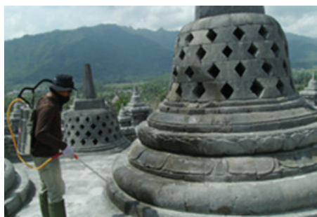
Penyemprotan \text{NaHCO}_3 1 % pada stupa teras (dok : BK Borobudur, 2010)
