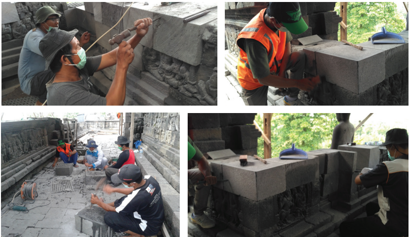
Foto 79-82. Perkuatan struktur pagar langkan dengan penambahan batu baru (dok: BK Borobudur)
