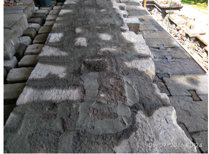
Foto 46, 47. Perbaikan layer B, dengan mengisi nat-nat dan rongga-rongga layer B dengan mortar (dok: BK Borobudur).
