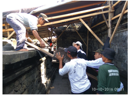
Foto 69-74. Penyusunan kembali patu penyusun pagar langkan (dok: BK Borobudur).
