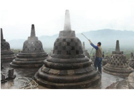
Pembersihan basah dengan air bertekanan (dok : BK Borobudur, 2014)
