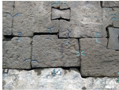
Foto 48, 49. Pembuatan batu kunci ekor burung“ pada dasar pagar langkan(dok: BK Borobudur).
