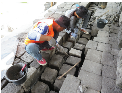
Foto 42, 43. Pembersihan saluran drainase bawah lantai kemudian dilakukan penutupan nat-natnya dengan mortar (dok: BK Borobudur).
