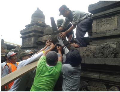
Foto 69-74. Penyusunan kembali patu penyusun pagar langkan (dok: BK Borobudur).
