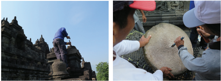
Foto 11,12. Penandaan stupa relung agar tidak tertukar dan dapat dipasangkan ke tempat semula (dok: BK Borobudur).
