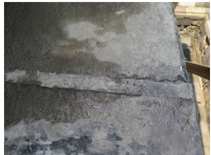
Foto 52, 53. Kondisi sambungan timbal yang kelihatan basah (dok: BK Borobudur).
