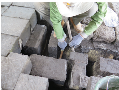
Foto 42, 43. Pembersihan saluran drainase bawah lantai kemudian dilakukan penutupan nat-natnya dengan mortar (dok: BK Borobudur).
