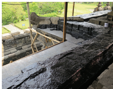
Foto 56-58. Aplikasi mortar pada lapisan timbal dalam dan layer B (dok: BK Borobudur).
