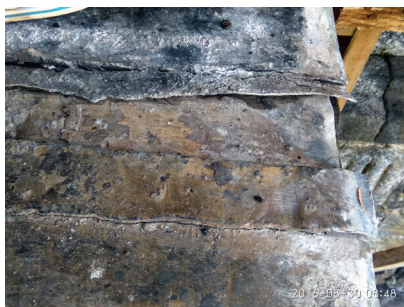
Foto 40, 41. Kondisi sambungan timbal yang berada pada dasar pagar langkan (dok: BK Borobudur).
