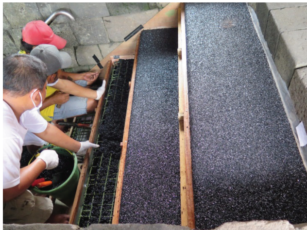
Gambar 12. Proses pembuatan model pelapis tangga candi (model dengan bahan karet granule)
