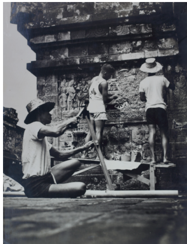
Foto 3. Pengujian AC 322 yang dicampur dengan lempung (dok:proyek pemugaran Borobudur)
