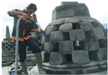
Pembersihan kering menggunakan vacuum cleaner pada stupa teras setelah erupsi Gunung Merapi tanggal 5 November 2010. (dok : BK Borobudur, 2010)
