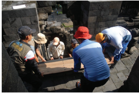
Gambar 13. Pemasangan pelapis tangga candi
