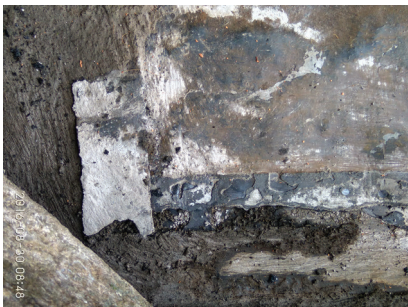
Foto 40, 41. Kondisi sambungan timbal yang berada pada dasar pagar langkan (dok: BK Borobudur).
