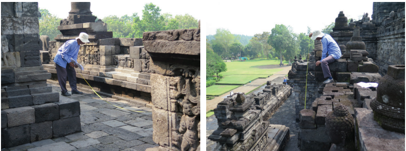
Foto 5,6. Pengukuran/survey ulang lokasi yang akan dibongkar (dok: BK Borobudur).
