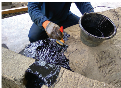
Foto 56-58. Aplikasi mortar pada lapisan timbal dalam dan layer B (dok: BK Borobudur).
