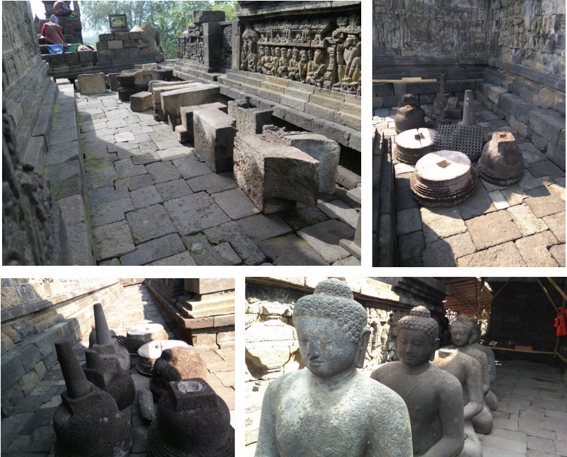
Foto 33-36. Penampungan batu penyusun relung pagar langkan, stupa dan arca (dok: BK Borobudur).
