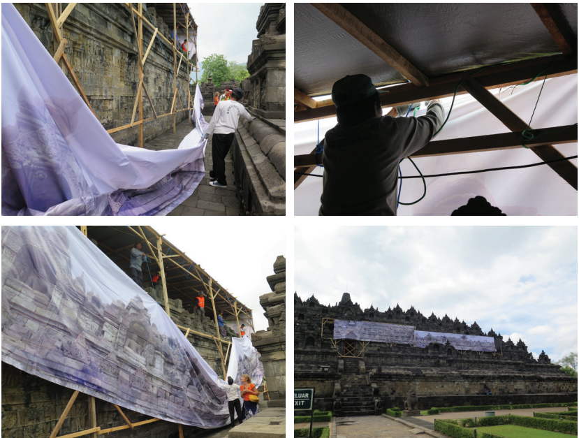
Foto 19-22. Pemasangan cover kamuflase pada lokasi pembongkaran kebocoran (dok: BK Borobudur).
