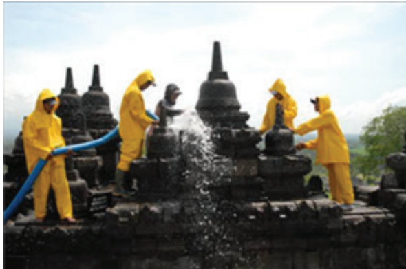
Pembersihan basah menggunakan kompresor pemompa air dan selang berukuran besar pada pagar langkan. (dok : BK Borobudur, 2010)
