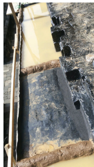
Foto 67, 68. Pengujian lapisan kedap air pada lapisan timbal depan layer B (dok: BK Borobudur).
