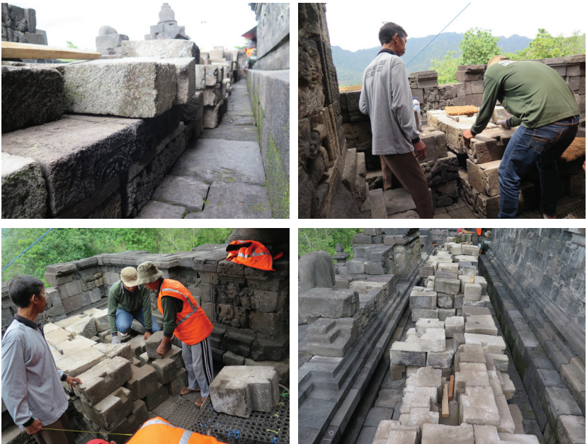
Foto 29-32. Situasi penampungan batu bongkaran (dok: BK Borobudur).
