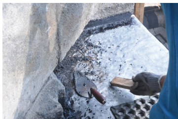
Foto 56-58. Aplikasi mortar pada lapisan timbal dalam dan layer B (dok: BK Borobudur).
