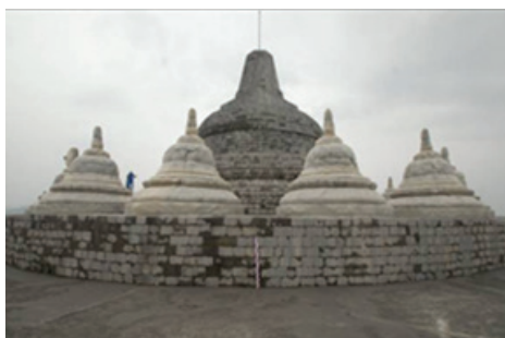
Penutupan stupa teras dengan plastik (dok : BK Borobudur, 2010)
