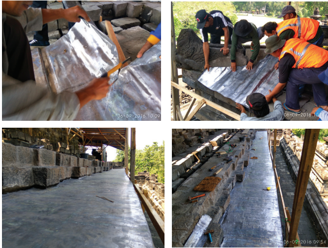
Foto 54, 55. Pemasangan lapisan timbal baru (dok: BK Borobudur).
