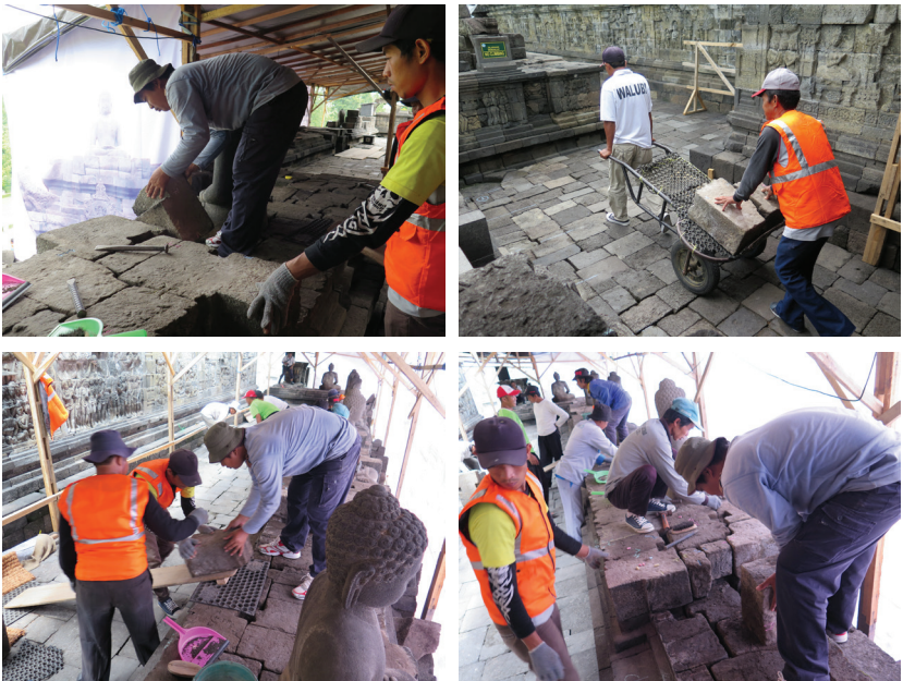
Foto 25-28. Proses pembongkaran stuktur pagar langkan (dok: BK Borobudur).
