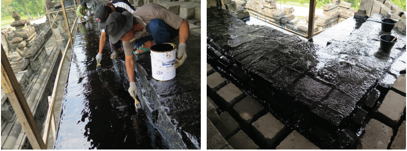
Foto 59-64. Pengolesan lapisan kedap air pada layer B dan lapisan timbal sebanyak 3 kali (dok: BK Borobudur).
