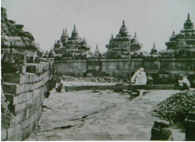
Foto 1. Proses restorasi I candi Borobudur (dok: Rep van Erp).
