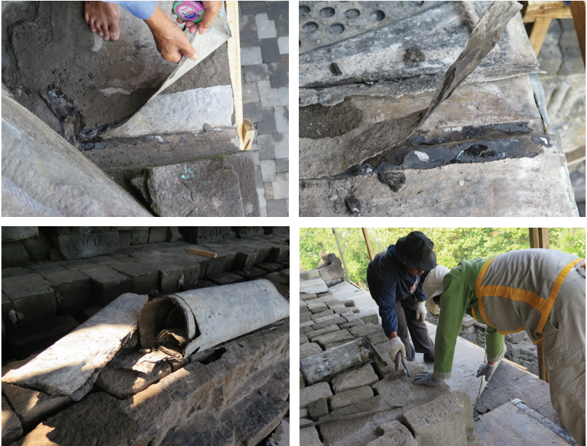
Foto 37-40. Pembongkaran lapisan timbal (dok: BK Borobudur).
