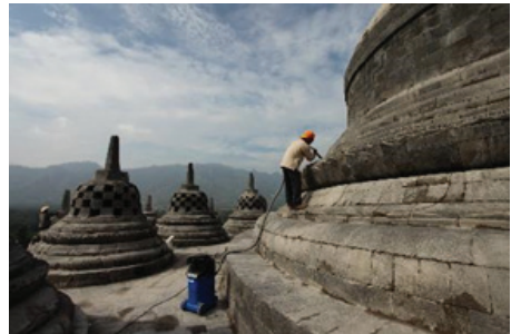
Pembersihan menggunakan vacuum cleaner pada stupa induk (dok : BK Borobudur, 2014)
