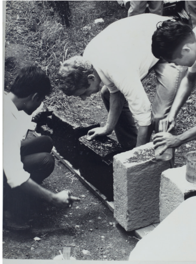
Foto 4. Pengujian bahan pelapis (dok: proyek pemugaran Borobudur).
