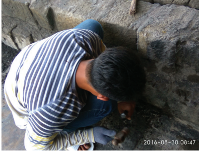
Foto 46, 47. Perbaikan layer B, dengan mengisi nat-nat dan rongga-rongga layer B dengan mortar (dok: BK Borobudur).
