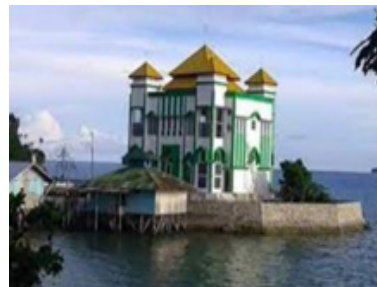
Masjid yang sudah di rehab pada Kampung Merapi Sebrang
