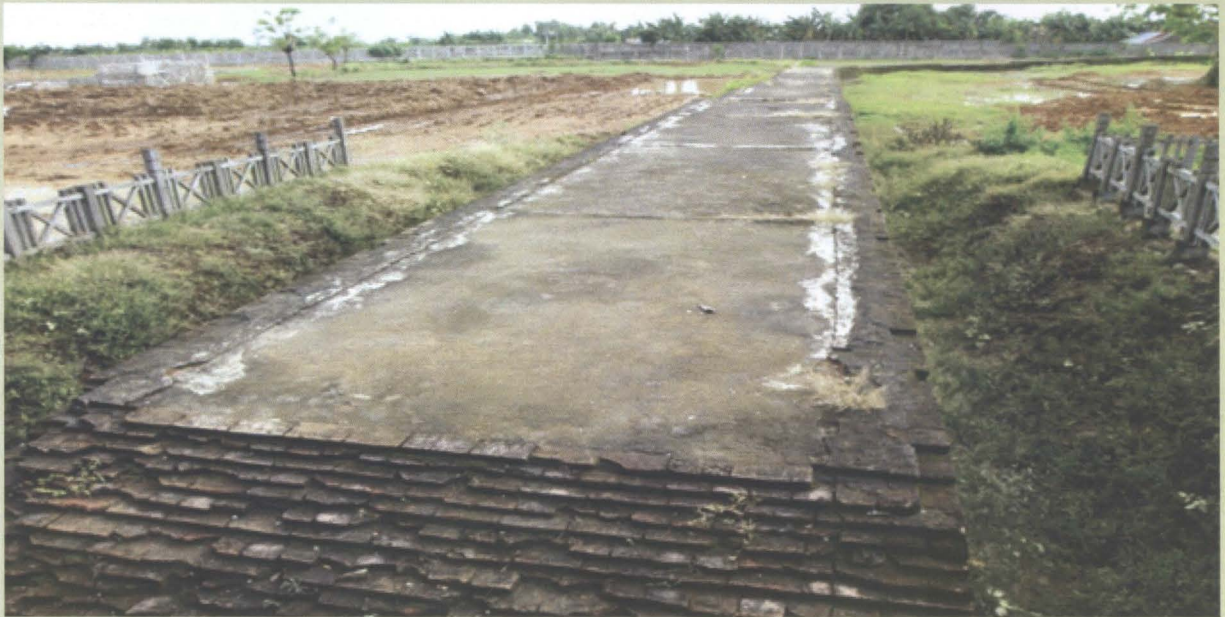
Foto 52 : Struktur dinding Benteng Somba Opu bagian timur
