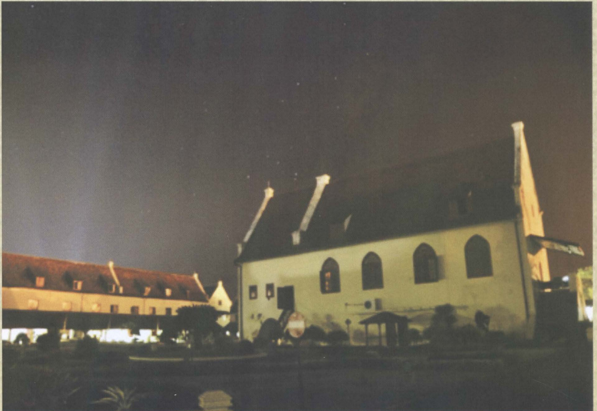
Foto 6 : Salah satu bangunan dalam Benteng Ujung Pandang/Fort Rotterdam yang pada masa kolonial difungsikan sebagai gereja (kini aula)
