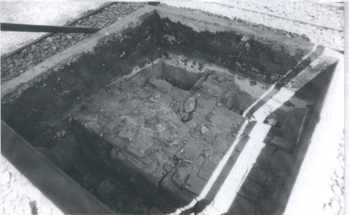
Foto 10: Galian di sisi Gereja Kristen di tengah-tengah benteng, menunjukkan konstruksi asli fondasi dari Benteng Ujung Pandang.
