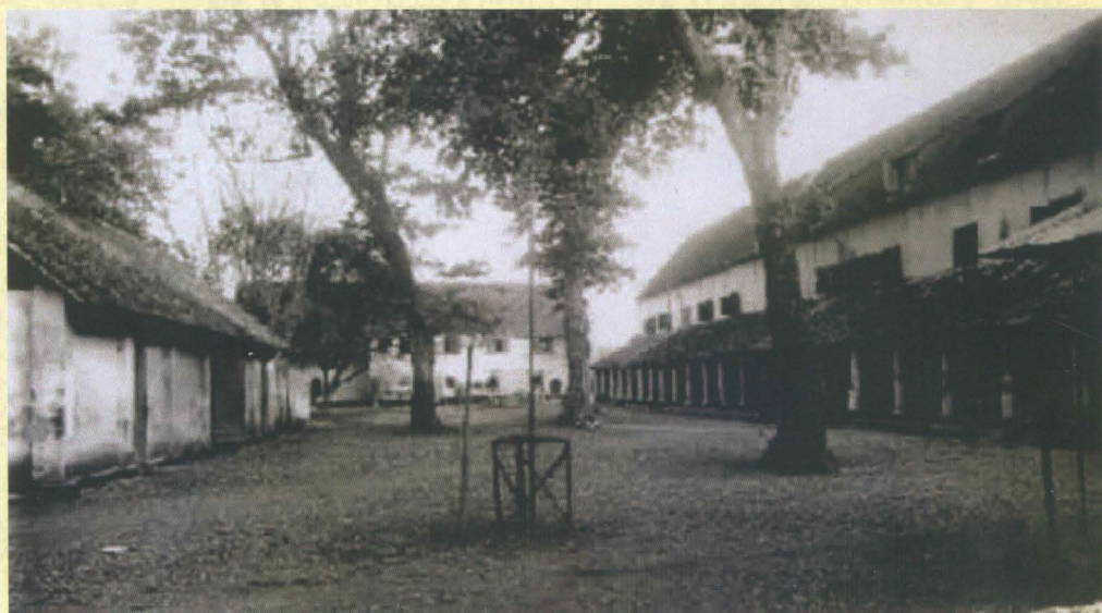
Foto 20: Unit gudang kompeni (lihat gambar No.1 15 s) di kanan, menempel sejajar dengan dinding selatan benteng, terdiri dari dua lantai, ditambah satu lantai di bawah atap langsung dengan teras panjang dan deretan kolom silindris mirip kolom Dorik, pada 1915-an, diujung terlihat Balai Kota (gambar 15 V). Gedung yang sama pada saat ini. Diujung terlihat kantor yang pada waktu itu disebut Balai Kota. (foto koleksi KITLV, Leiden) (lihat pula foto 13 di bawah).
