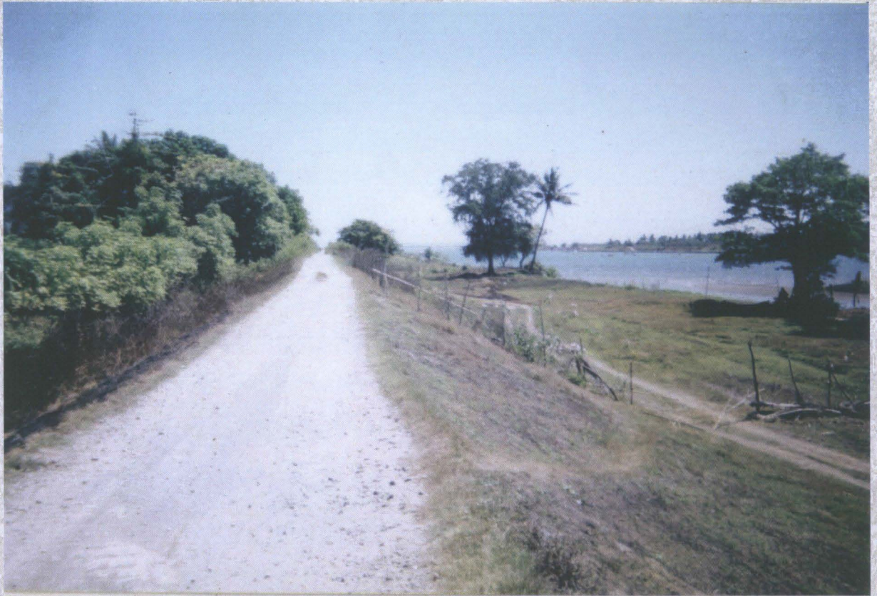
Foto 25: Permukaan tanggul yang memotong dinding Benteng Garassi untuk jalanan yang menghubungkan Kampung Taenga di sebelah timur dengan Kampung Panakkukang di sisi barat situs.
