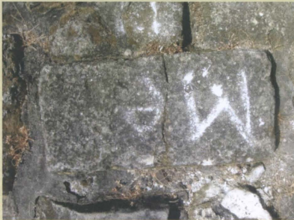
Foto 35, 36 Keadaan batu benteng yang pecah, retak dan patah.
