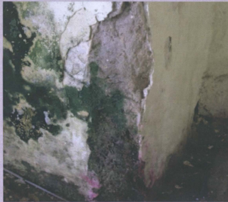
Foto 44, 45 : Kapilarisasi pada dinding bangunan benteng
