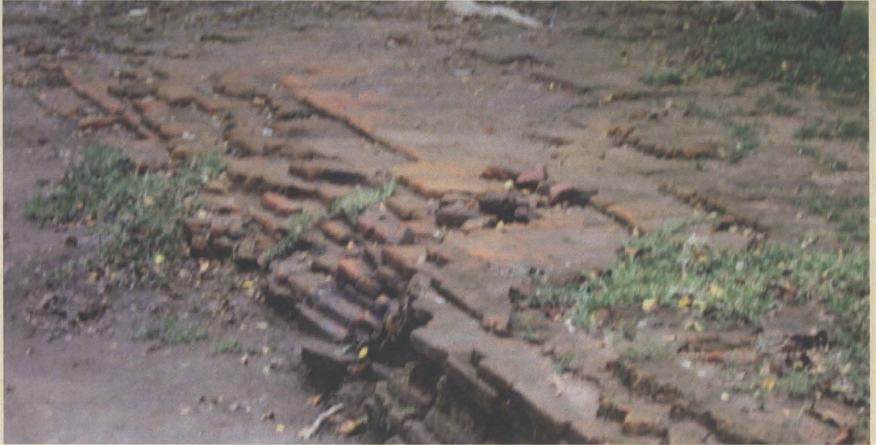
Foto 60 : Struktur batu yang mulai lapuk dan aus
