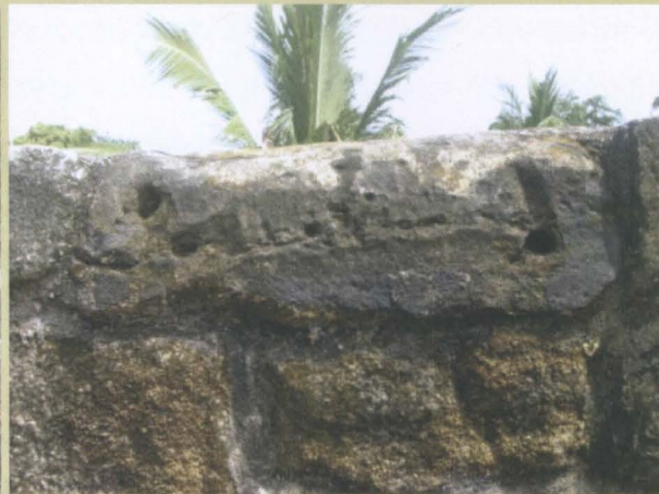
Foto 35, 36 Keadaan batu benteng yang pecah, retak dan patah.
