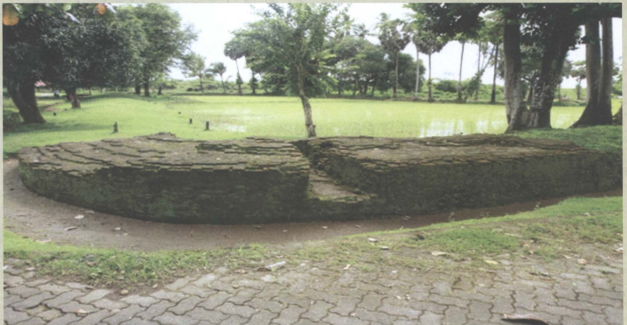
Foto 51 : Struktur dinding benteng bagian selatan
