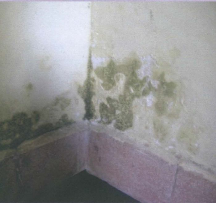
Foto 44, 45 : Kapilarisasi pada dinding bangunan benteng
