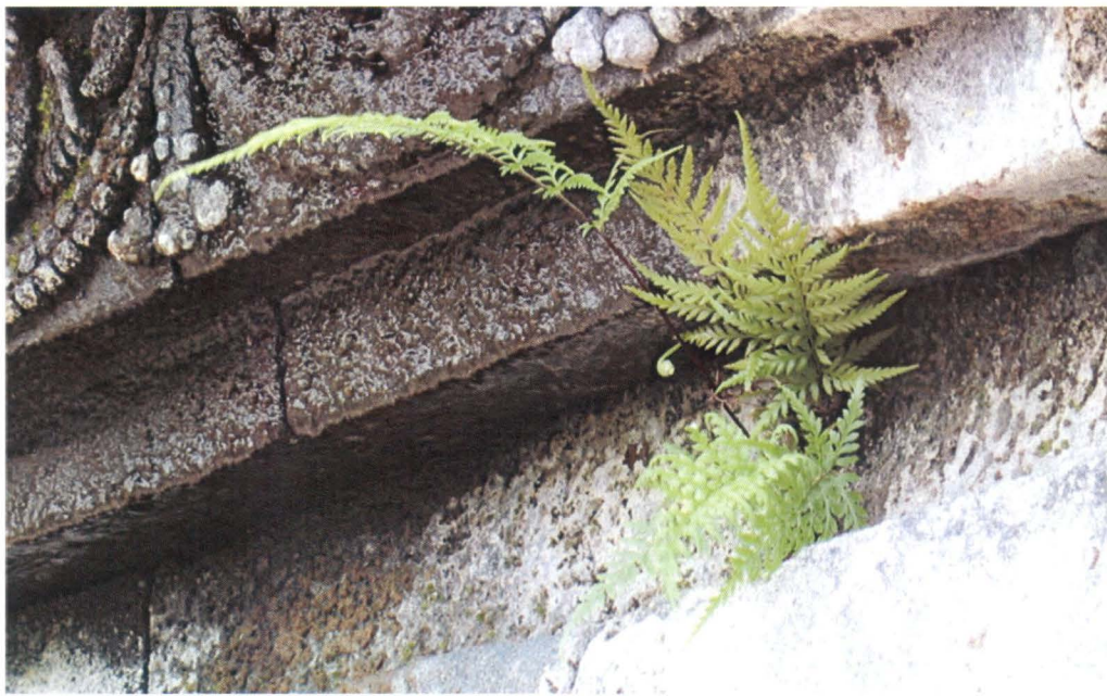
Pertumbuhan alga berbentuk lendir (pada bagian berair), lumut kerak (warna putih pada bagian kering, lembab) kanan atas, lumut dan tumbuhan paku.
