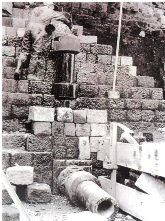
Proses pemasangan pipa drainase (kiri). Pengolesan araldite tar pada bagian luar pipa drainase (tengah). Lapisan batu yang diberi araldite tar (kanan).
