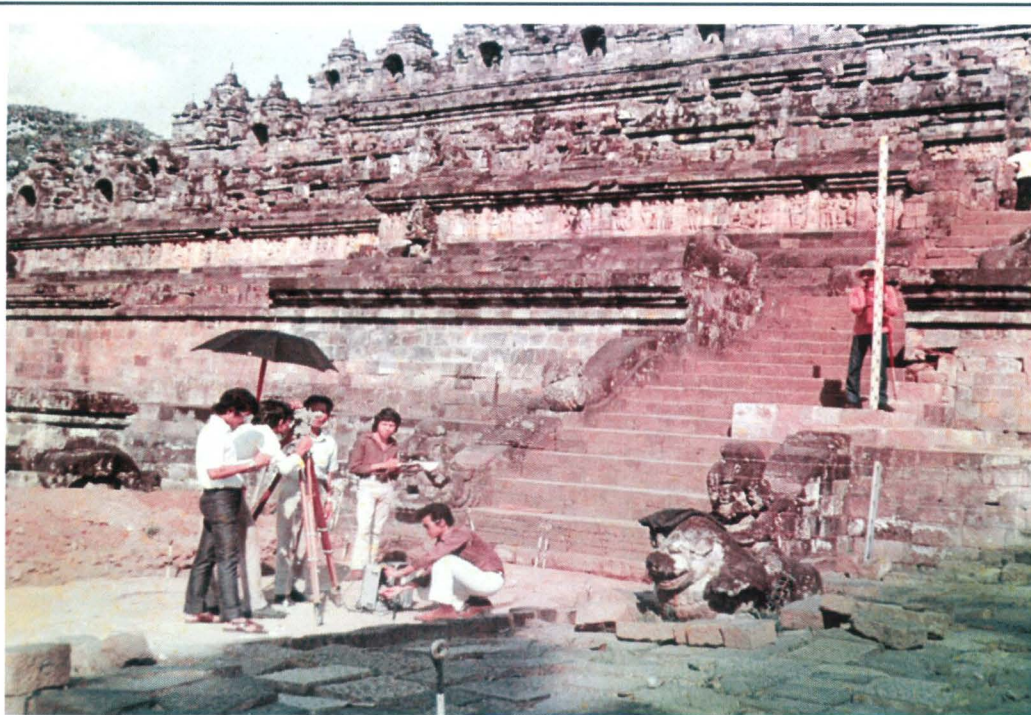
Pengukuran titik poligon menggunakan teodolit
