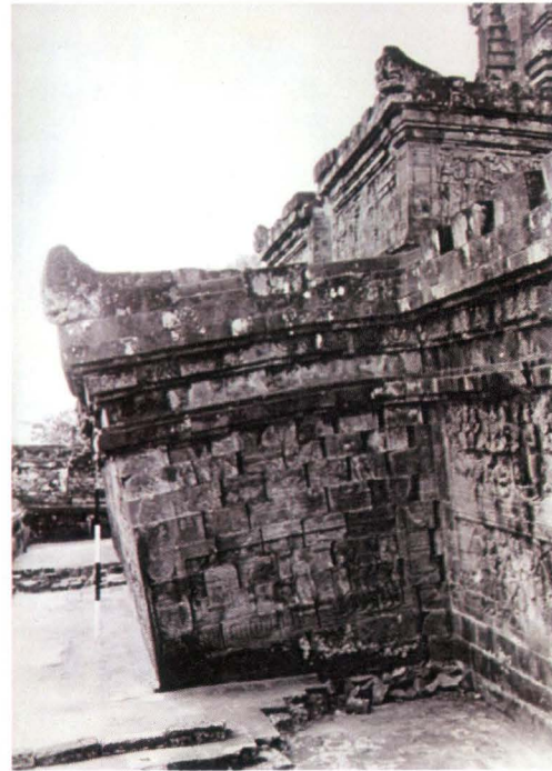
Dinding candi Borobudur yang terlihat miring dan melesak serta nat-nat batu yang semakin melebar.
