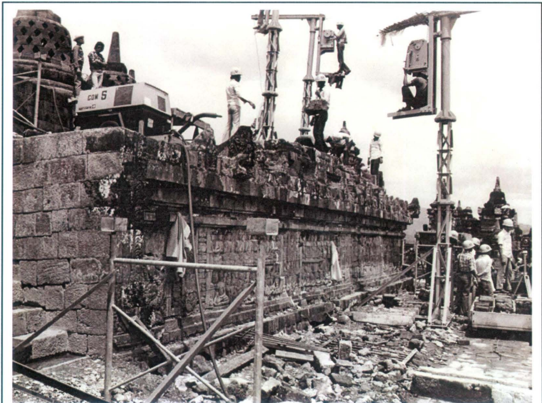
Suasana pekerjaan pembongkaran (dismantling) pada salah satu bagian candi
