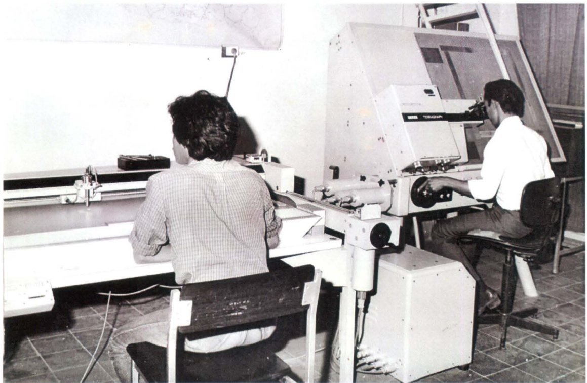
Proses penggambaran menggunakan stereoplotter dan meja gambar
