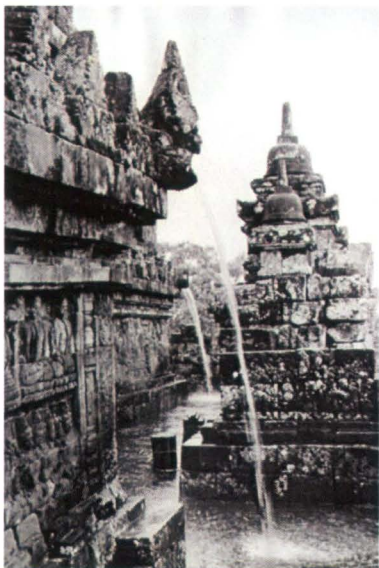
Jaladwara yang berfungsi sebagai sistem drainase untuk mengalirkan air ke luar dari candi
