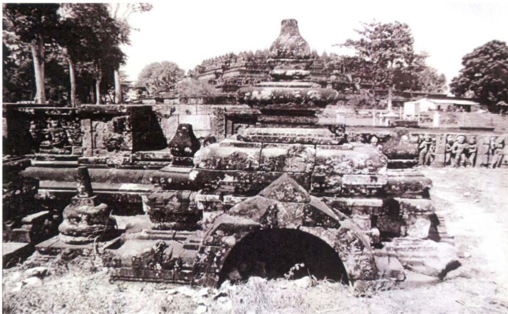
Rekonstruksi bagian candi yang dilakukan di halaman
