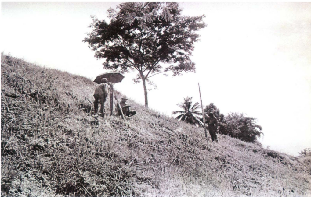
Pengukuran topografi menggunakan theodolith
