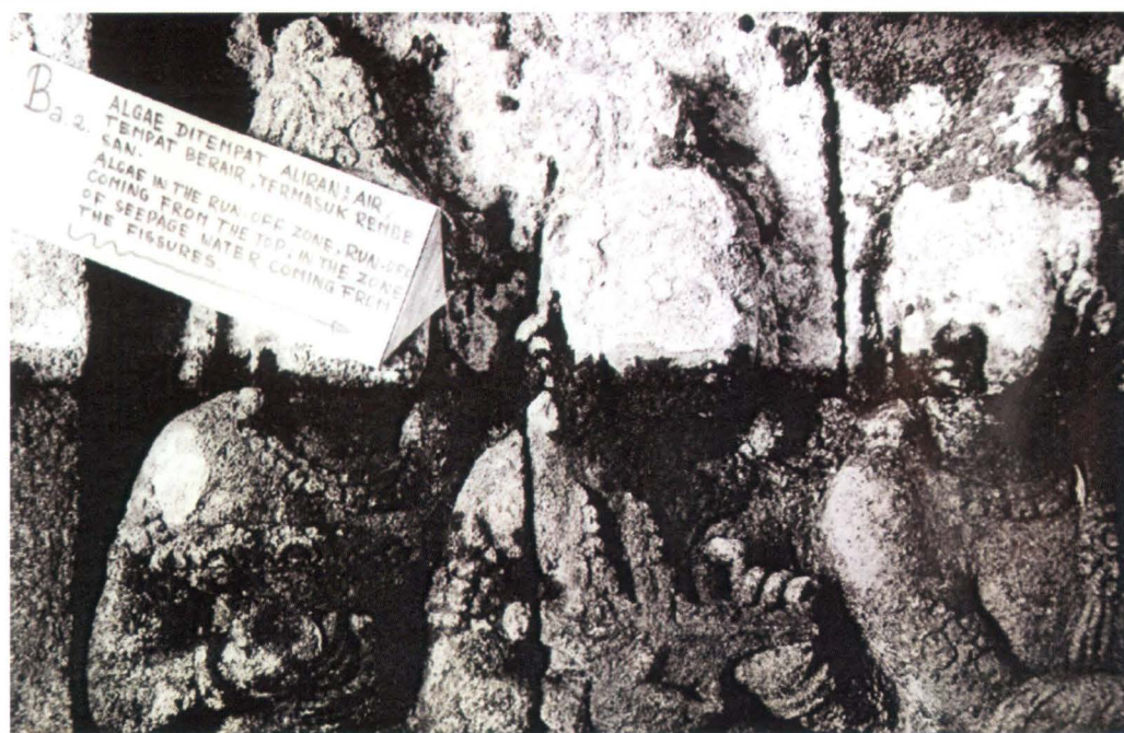
Kondisi relief yang mengalami keausan serta ditumbuhi lumut dan algae
