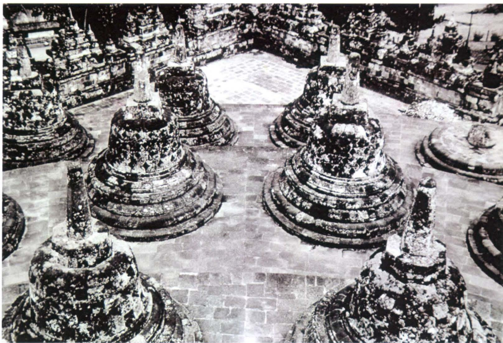
Kondisi stupa Candi Borobudur yang dipenuhi oleh lumut kerak
