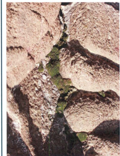
Pertumbuhan lumut (pada relief yang kering, lembab), batu yang mengelupas bekas bisul, dan endapan garam berwarna putih. Sekitarnya berwarna coklat muda karena sisa oker
