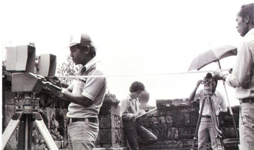
Pengangkutan menggunakan tower crane (atas). Peralatan-peralatan yang digunakan dalam pemugaran Candi Borobudur. Kamera stereoskop untuk fotogrammetri dan teodolit untuk pengukuran. (bawah).
