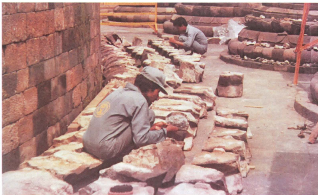
Pekerjaan Identifikasi dan Klasifikasi Batu.
