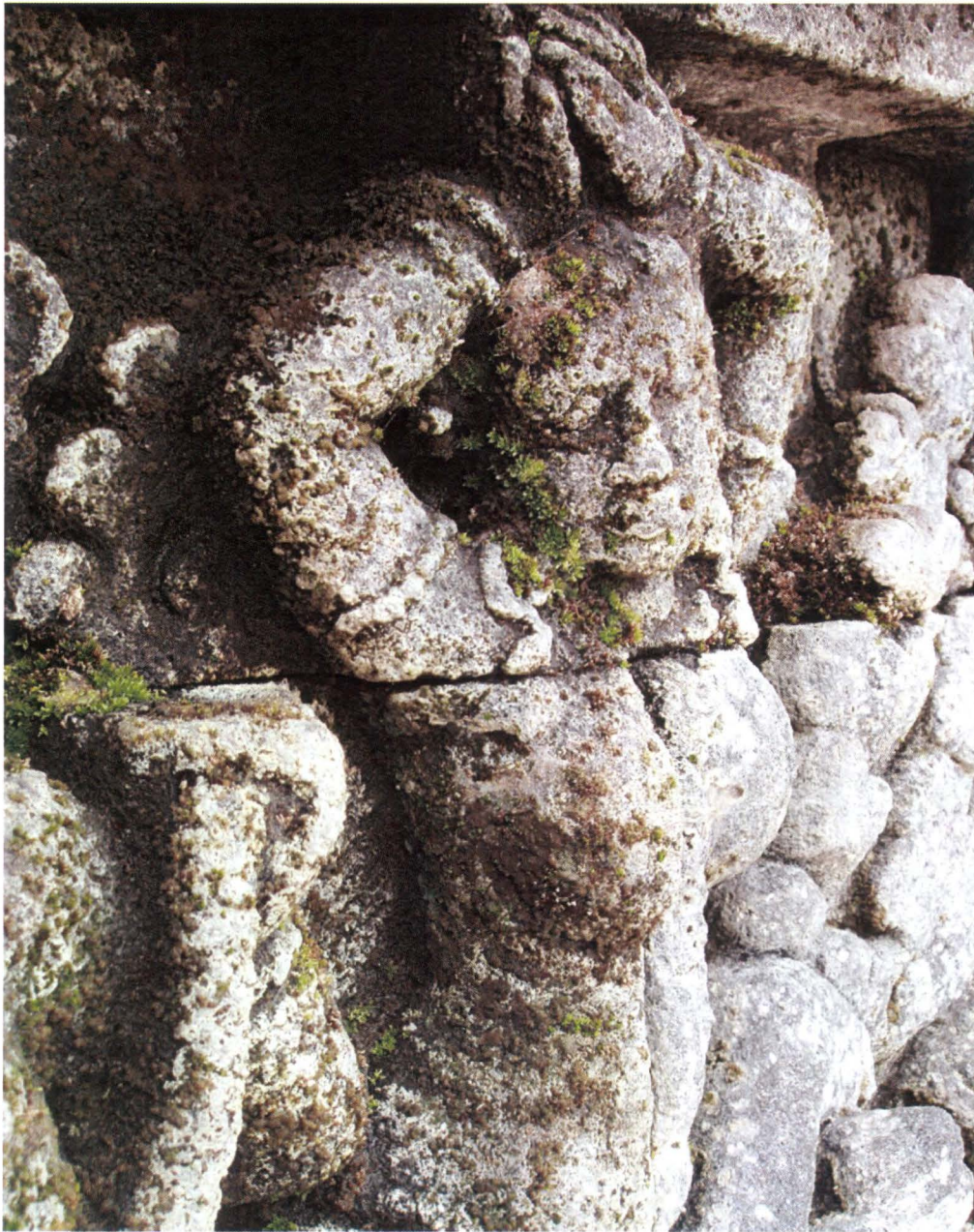
Pertumbuhan lumut (pada relief yang kering, lembab), lumut kerak (warna putih pada bagian kering, lembab), lumut dan tumbuhan lain. Terlihat adanya bisul, lubang-lubang bekas bisul dan endapan garam berwarna putih.
