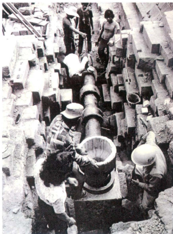
Proses pemasangan pipa drainase (kiri). Pengolesan araldite tar pada bagian luar pipa drainase (tengah). Lapisan batu yang diberi araldite tar (kanan).
