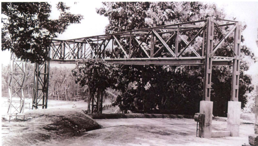
Gantry crane yang berada di sebelah barat daya Candi yang berfungsi untuk menurunkan pallet ke area kerja.
