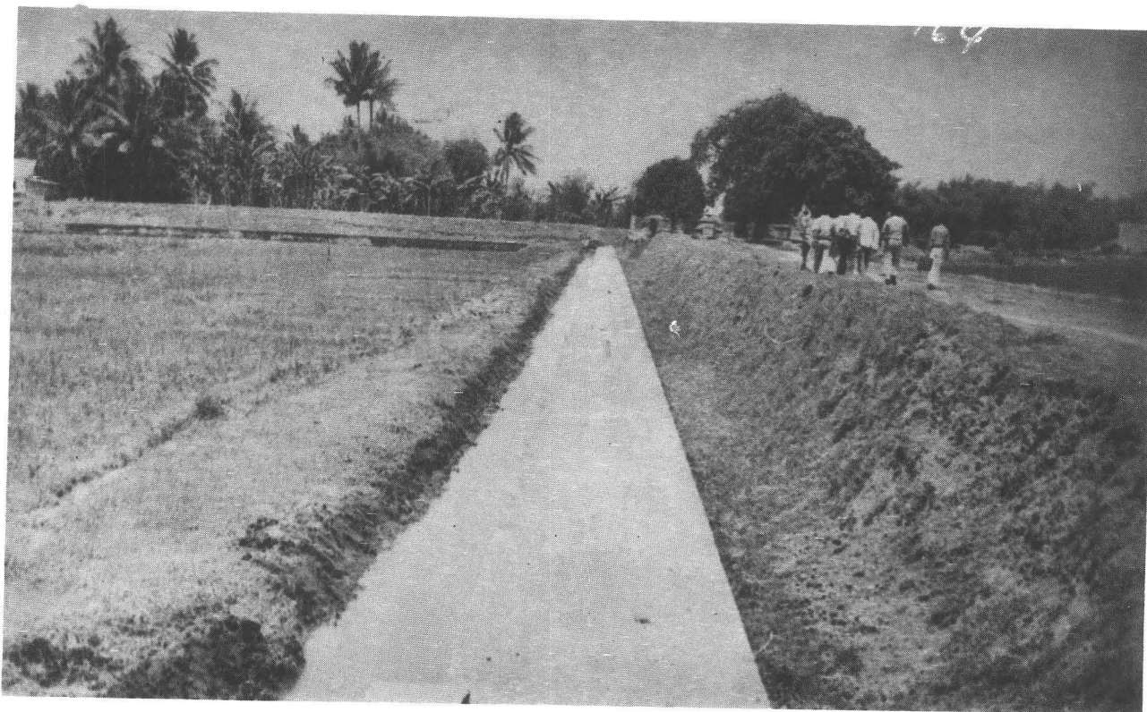
Gb. 106 SEGARAN dinding sebelah selatan (Foto koleksi DSP. th 1978).
