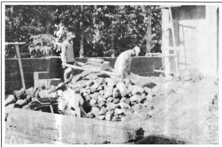
Gambar 18. Aktivitas pekerja bangunan
