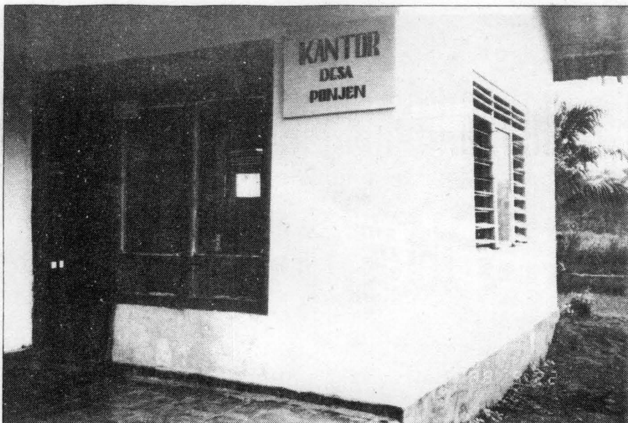
29. Bangunan Kantor Desa Ponjen yang menyatu dengan bangunan Balai Desa Ponjen.
